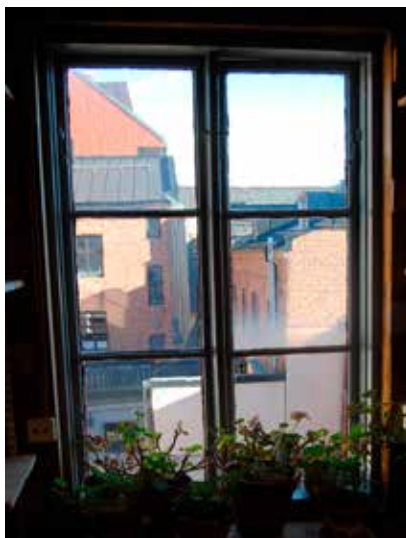
Det vackra fönstret på västra länsgans vind är troligen från byggnadens uppförande.
