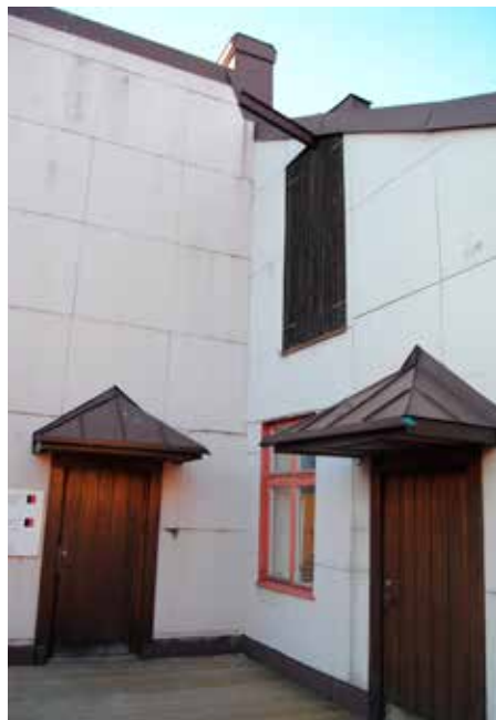
I den västra längans fasad mot gården finns plats att ta upp fler fönsteröppningar. Även lastluckans öppning t.h kan användas för ljusinsläpp. Nya fönster bör ha likadan utformning som befintligt vindsfönster.
